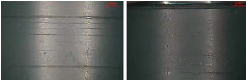
Abb. 38: P2-Gleitlager, Riefen in der Lauffläche
