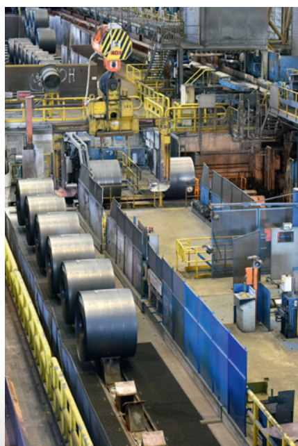
Impianto di laminazione in acciaieria
