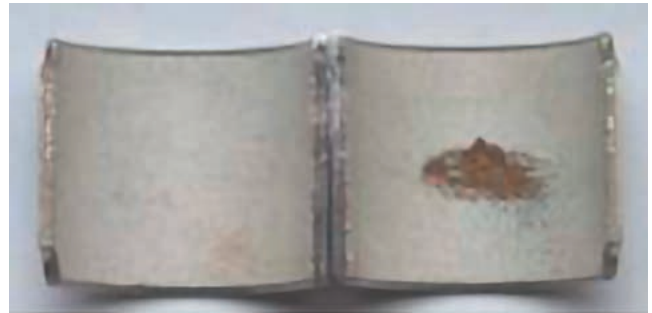
Fig. 36 : Dommage localisé par cavitation
